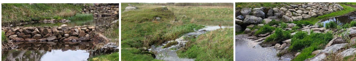
Eksempler på terskler eller overrisslingssoner i tre renseseparker på Jæren. Foto: Eva Skarbøvik.
