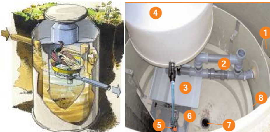
Figur 19. Kjemiske rensetrinn i et Wallax anlegg.
