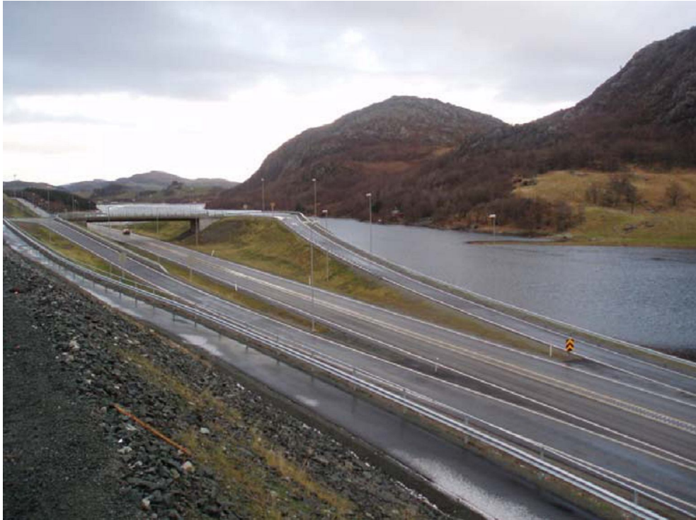
Bilde 4.1.1.a Veianlegg langs Klugevatnet (Foto: Fylkesmannen i Rogaland)
