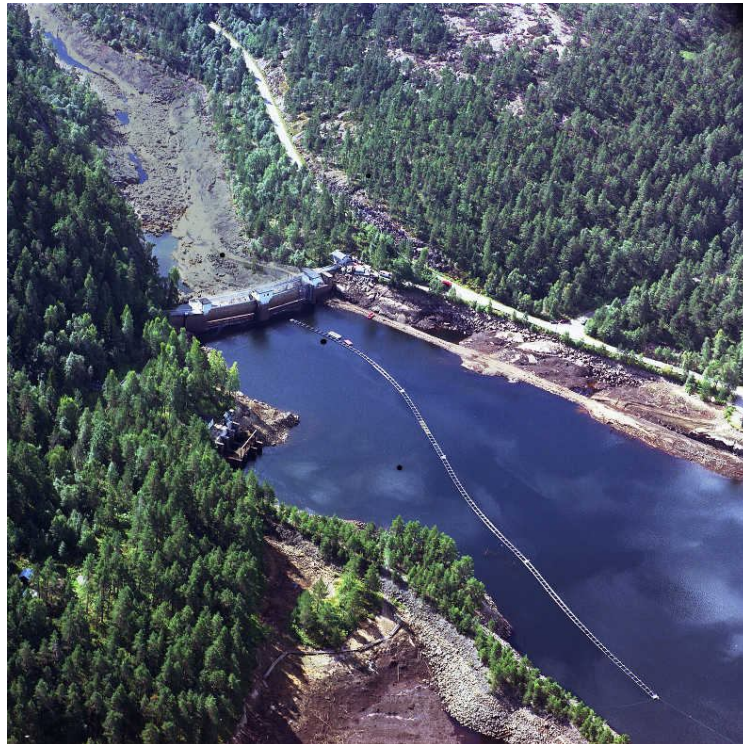
Bilde 3.1.1.a: Gåseflådammen i Vennesla/Iveland. Denne dammen er bygd for å forsyne inntaket til Iveland kraftverk. Kraftverket ligger 3,5 km nedstrøms dammen. Denne strekningen tilføres ikke vann fra hovedløpet oppstrøms i de perioder der vannføringen i hovedløpet er lavere enn kraftverkets slukeevne. Foto: Tor Kviljo, Terrateknikk
