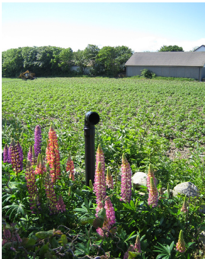
Utluftning av slamavskiller
