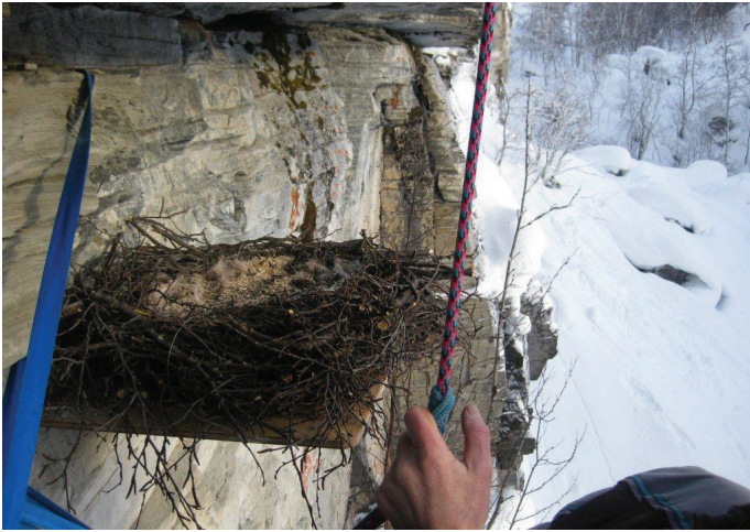
Platereir under overheng med kvistring og løsmasse i midten
