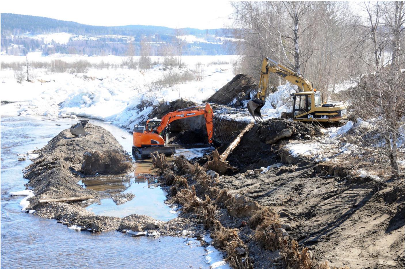
TESTES: Naturbaserte metoder for erosjonssikring i Norge testes ut i Gjødingelva i Hurdal. Foto: Helge B. Pedersen
